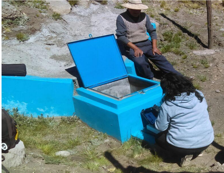
Figura 12: Toma de muestra ( Pozo N° 3) C.P. de Coata
